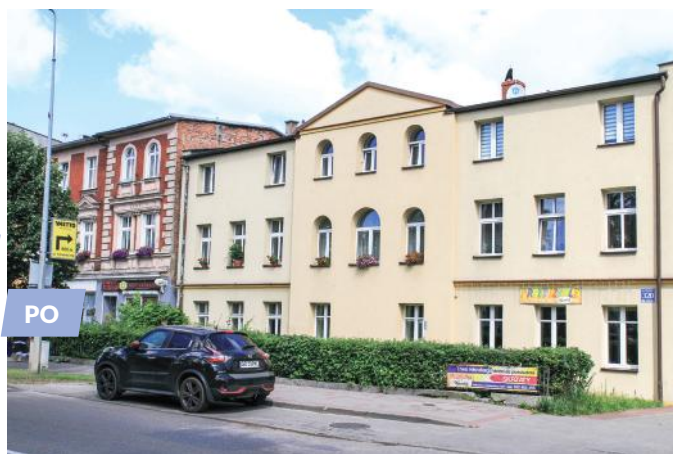
Budynek przy ul. Sobieskiego 320
