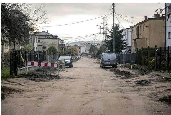
Budowa ul. Niskiej
