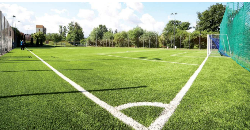
Nawierzchnia na boisku przy ul. Partyzantów
