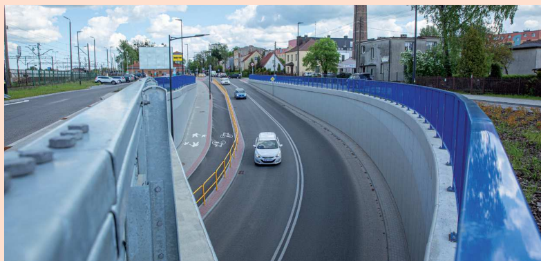
Węzeł Wejherowo (Kwiatowa) z tunelem pod torami kolejowymi i parkingiem przy dworcu PKP
